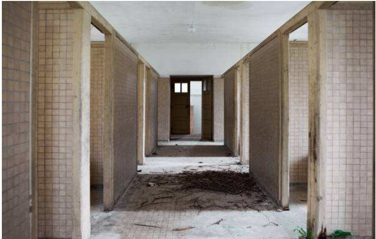
Anciennes salles de bain, hôpital de Picauville (Manche), 2010. Photographe: ©Mathieu Pernot
