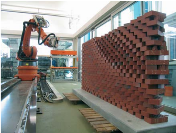
F. Gramazio, M. Köhler, D. FaB, Fabrication robotisée d'un mur en brique © Gramazio & Köhler, Architektur und Digitale Fabrikation, ETH Zürich
